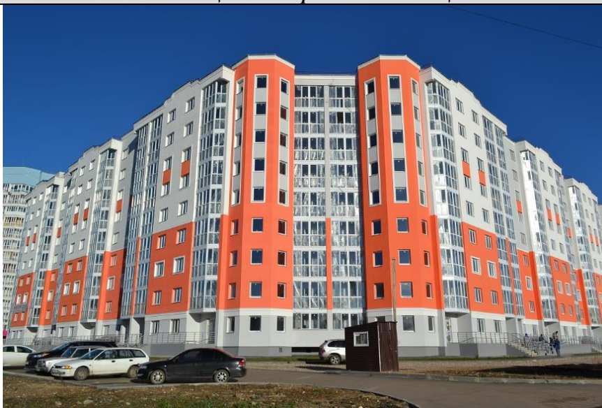
Фото 1 Общий вид строительной площадки 4
