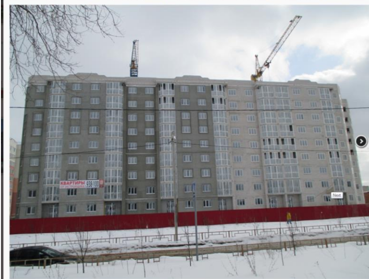
Фото 1 Общий вид строительной площадки (март 2018 года)
