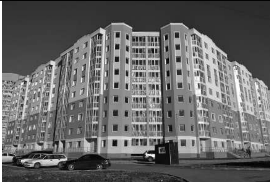
Фото 1 Общий вид строительной площадки 4
