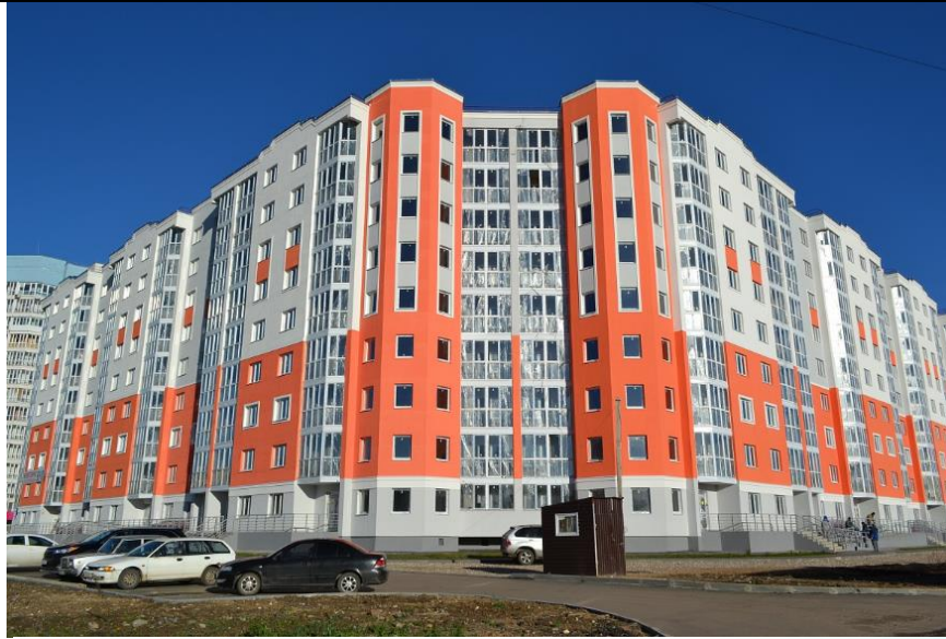
Фото 1 Общий вид строительной площадки 4
